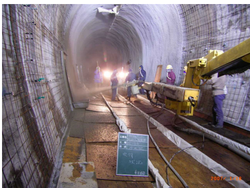
【城山トンネル補強工事】
