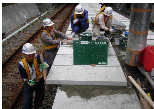
【伊豆熱川駅ホーム改修】
