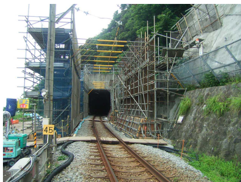
【水下トンネル(伊東方)落石覆い工事】
