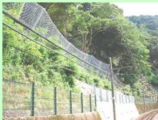
【稲梓駅～蓮台寺駅間法面補強工事】
