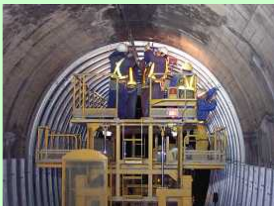
【朝日台トンネル補強工事】
