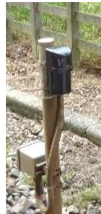
【踏切障害センサー】
