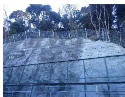
【松川橋梁付近の法面防護工事】
