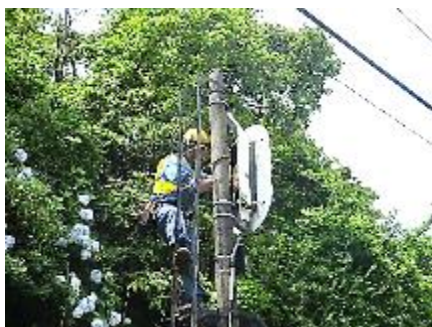
【信号機整備作業】
