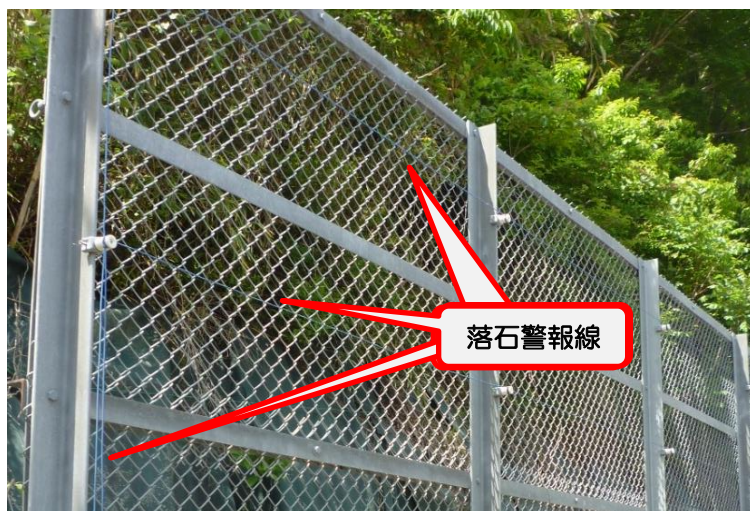
【落石防護フェンスに敷設している落石警報線】
