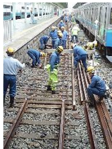
【レール交換工事】
