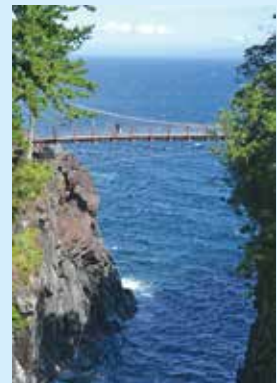
3 门肋吊桥 門脇吊橋
