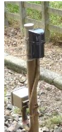
【踏切障害センサー】
