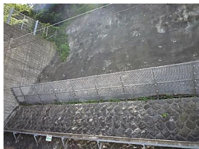
【落石受けフェンス】
