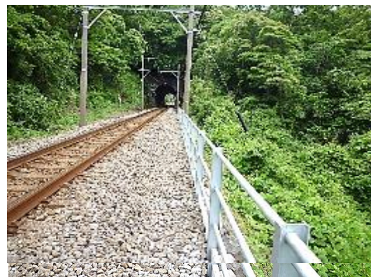
【線路上に設けられた転落防止柵】
