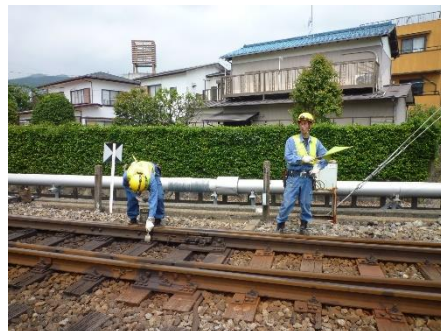
【転てつ器の点検】
