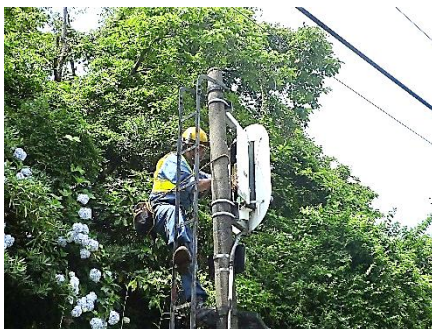
【信号機整備作業】
