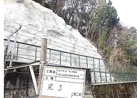
【松川橋梁付近の法面防護工事】
