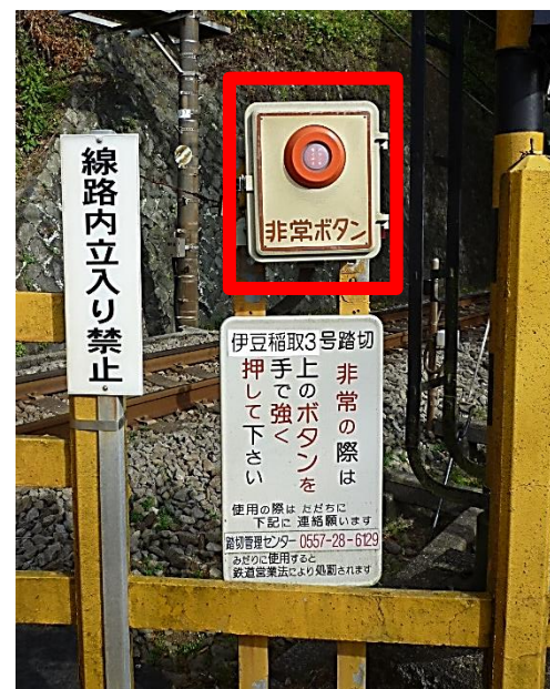
【非常押しボタン】
