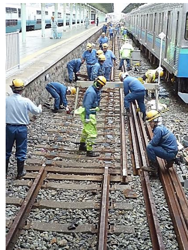
【レール交換工事】
