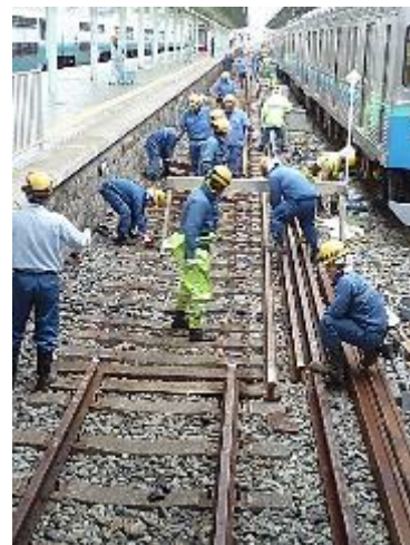
【レール交換工事】
