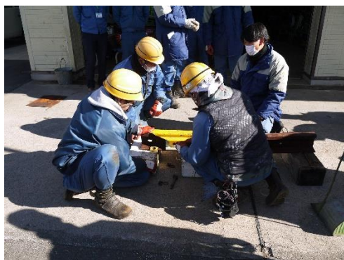
— レール折損時の応急復旧訓練 — (保線区)
