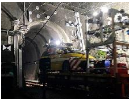
【構造物検査の様子】
