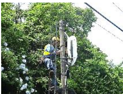
【信号機整備作業】
