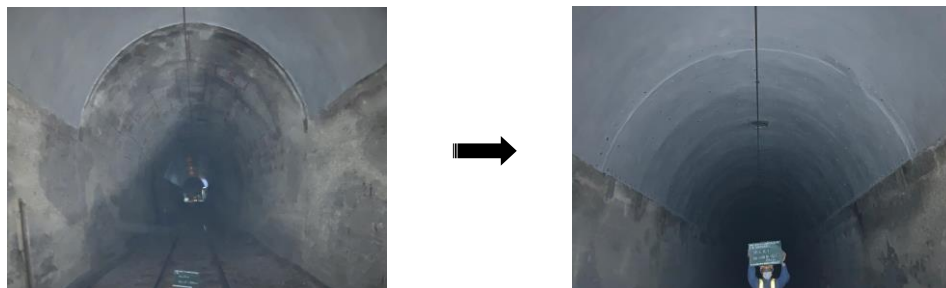
【トンネル補強工事】
