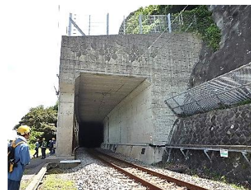
【落石防護覆い】
