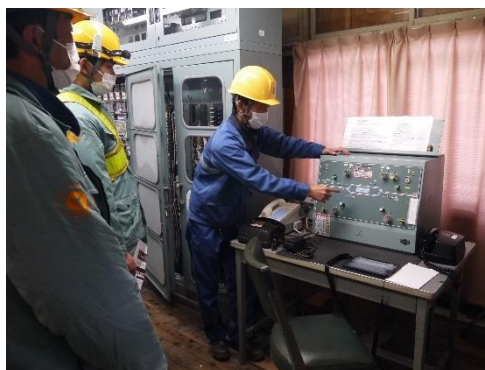
— 信号トラブル時の復旧訓練 — (電気区)
