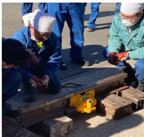
【レール折損時の応急処置訓練（保線区）】
