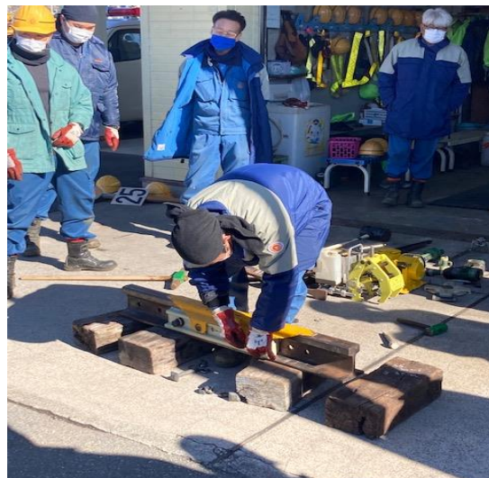
【レール折損時の応急処置訓練（保線区）】
