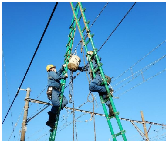
【トロリー線断線時の復旧訓練（電気区）】
