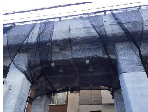
【白田高架橋剥落防止ネット設置工事】
