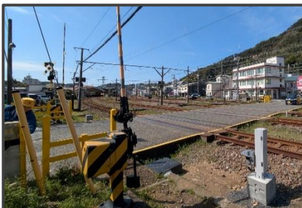
【蓮台寺 1 号踏切と障害物検知センサー】
