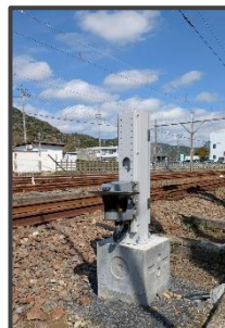
【蓮台寺 1 号踏切と障害物検知センサー】
