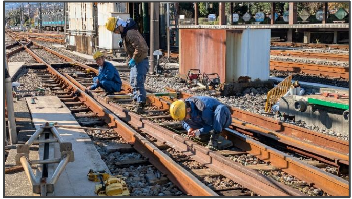
【ポイント交換工事】
