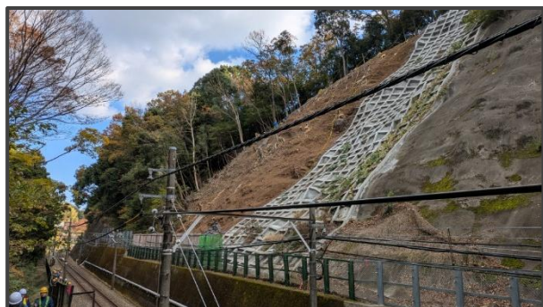
【富戸トンネル上口法面防護工事進捗状況】
