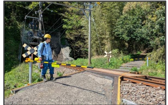
【簡易遮断機（片瀬白田 1 号踏切）】
