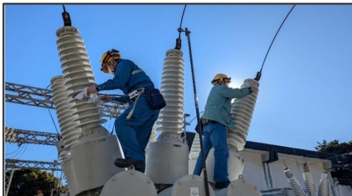
【変電設備の点検】
