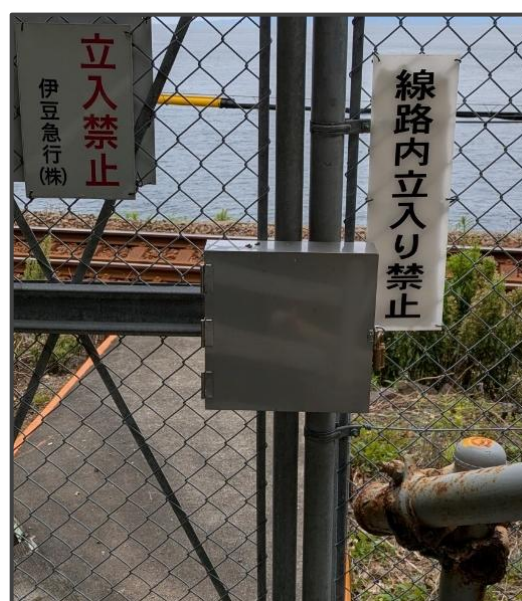
【線路内侵入防止用の囲い（鍵つき）】
