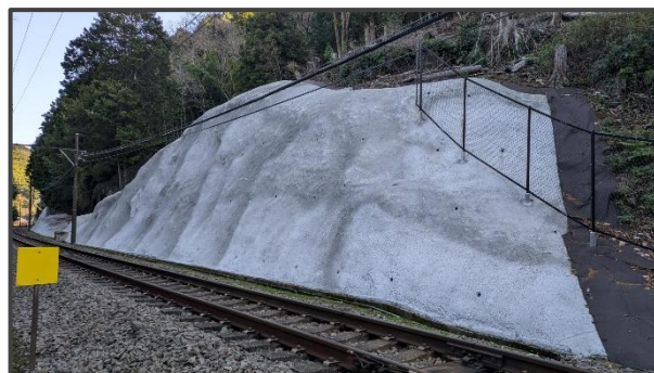
【谷津第4橋梁付近法面補強工事】
