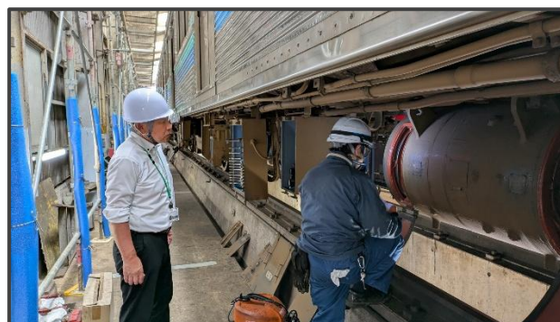
【安全統括管理者による現場巡視】
