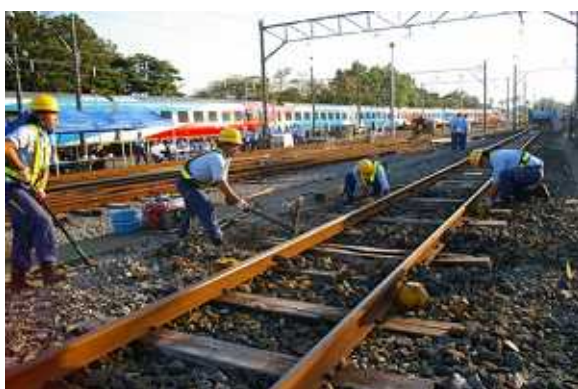
【軌道復旧作業】
