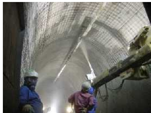
【朝日台トンネル補修工事】
