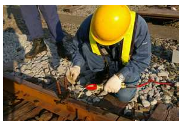
【信号施設復旧作業】
