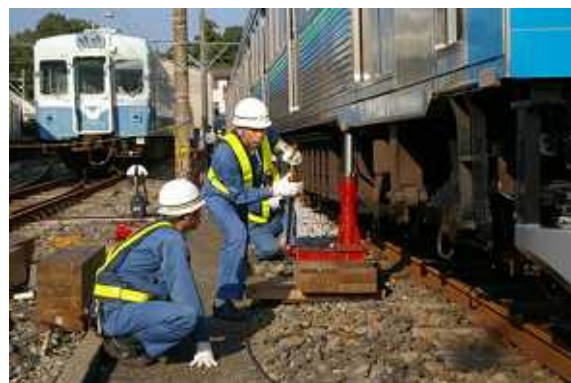
【脱線復旧作業】
