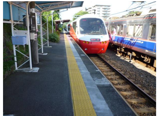
【富戸駅警告ブロック】
