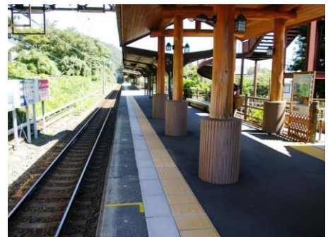
【警告ブロック】
