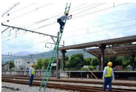
【電路設備の検査】
