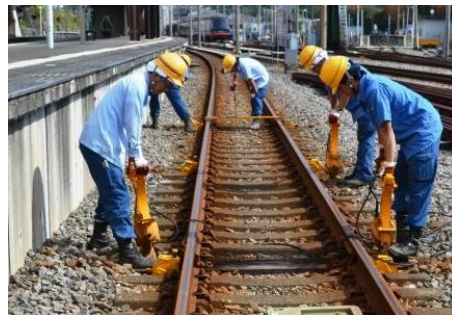
【道床のつき固め】
