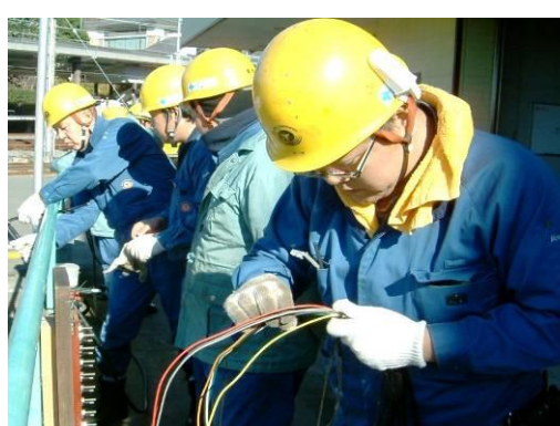
【応急復旧訓練「信号故障時の復旧訓練」】 (電気区)
