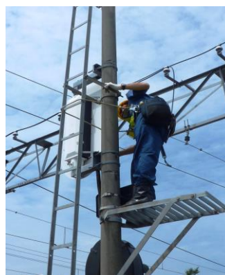
【信号設備の検査】
