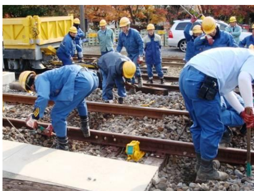
【応急復旧訓練「マクラ木交換訓練」】 (保線区)
