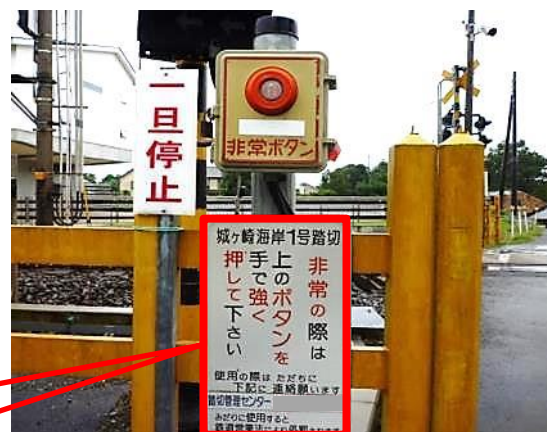
【非常押しボタン】
