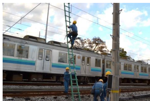
【損傷した電車線の復旧作業】
