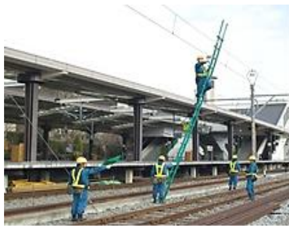
【電路設備の点検】
