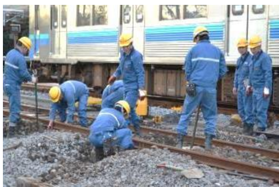
【損傷した線路の復旧作業】
