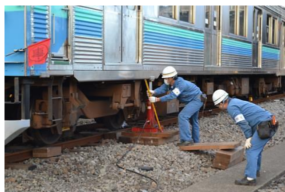
【脱線した車両の復旧作業】
