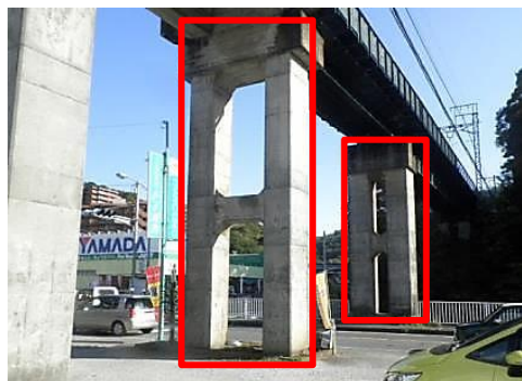
【緊急輸送道路（県道12号伊東～修善寺線）と交差する架道橋の耐震補強】
