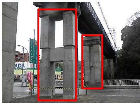
【緊急輸送道路（県道12号伊東～修善寺線）と交差する架道橋の耐震補強】
