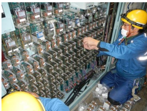
【信号設備の点検】
