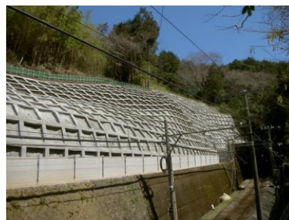
【万畑トンネル坑口付近の法面防護工事】
