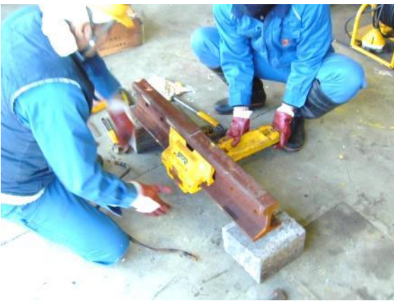
【レール折損時における応急復旧訓練】 （保線区）
