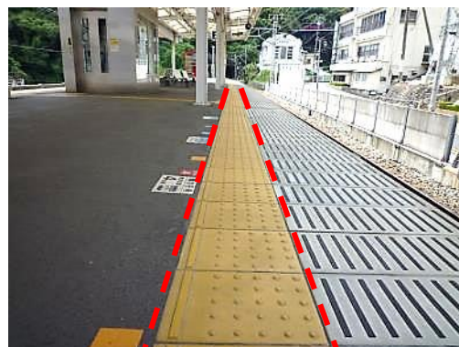
【警告ブロック】
