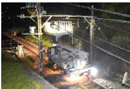
【夜間電気作業】
