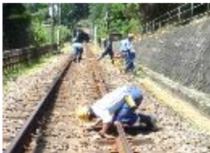
【線路の歪み修正】
