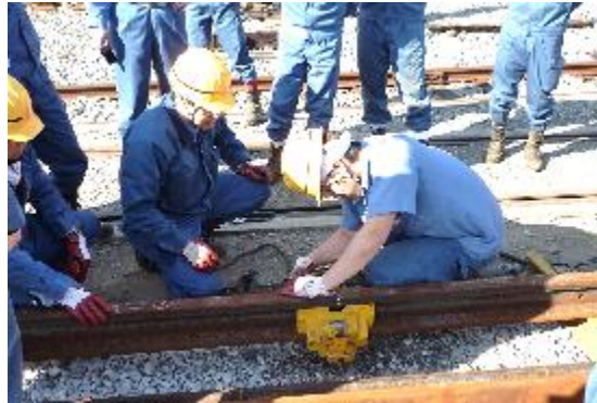
【レール折損時における応急復旧訓練】 (保線区)
