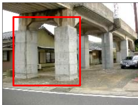
【緊急輸送道路（県道 14 号下佐ヶ野谷津線）と交差する架道橋の耐震補強】
