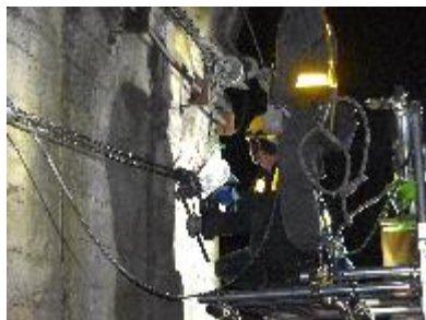
【夜間電気作業】
