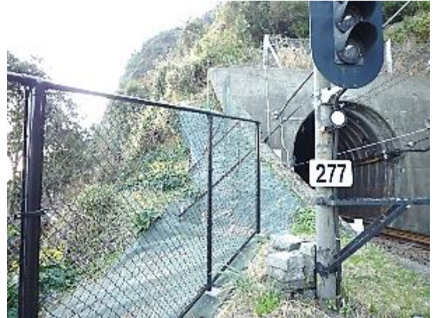
【黒根トンネル（伊東方）における防獣柵設置】
