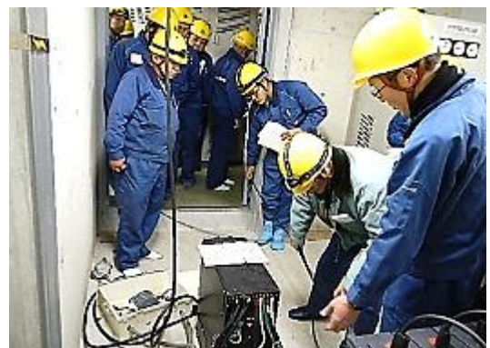
【東京電力停電時における緊急対応訓練】 （電気区）
