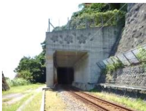
【落石防護覆い】
