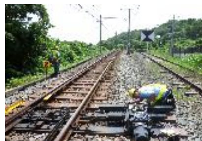
【転てつ器の点検】
