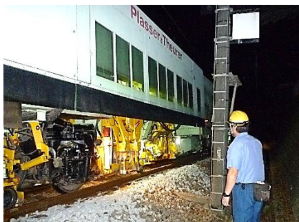
【マルチフルタイタンバーにて軌道整備】 ※ JR東日本借り受け
