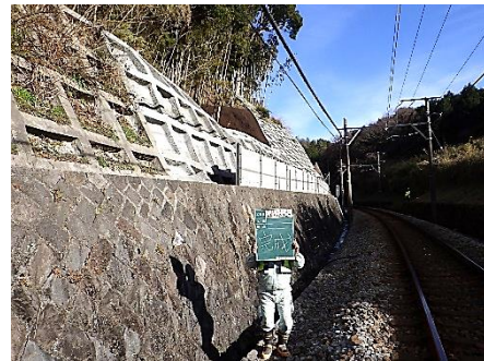
【万畑トンネル坑口付近の法面防護工事】
