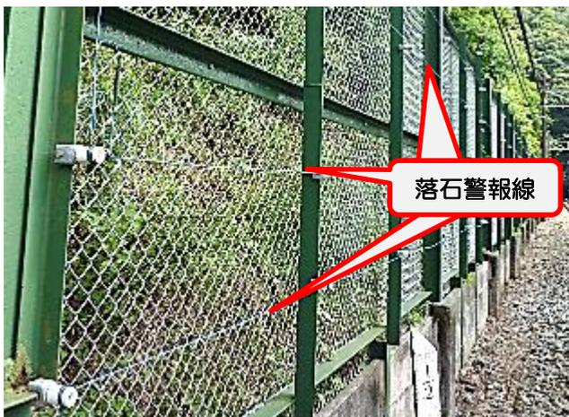
【落石防護フェンスに敷設している落石警報線】
