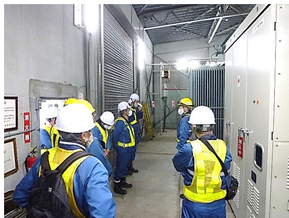
【経営陣による駅区巡視（変電所）】
