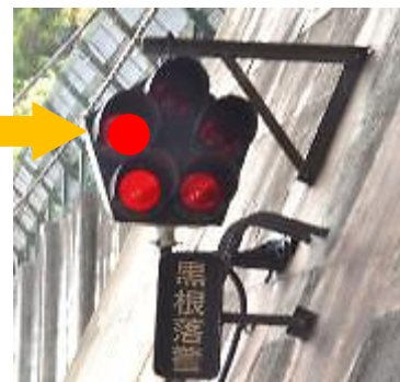
【落石警報機（動作中）】
