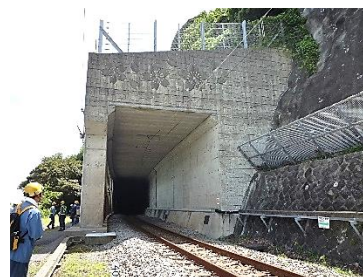
【落石防護覆い】
