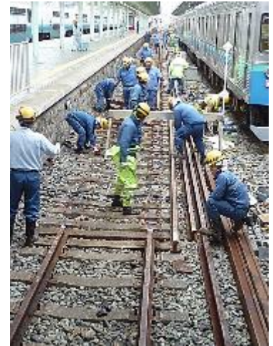
【レール交換工事】
