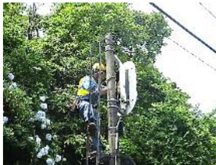
【信号機整備作業】
